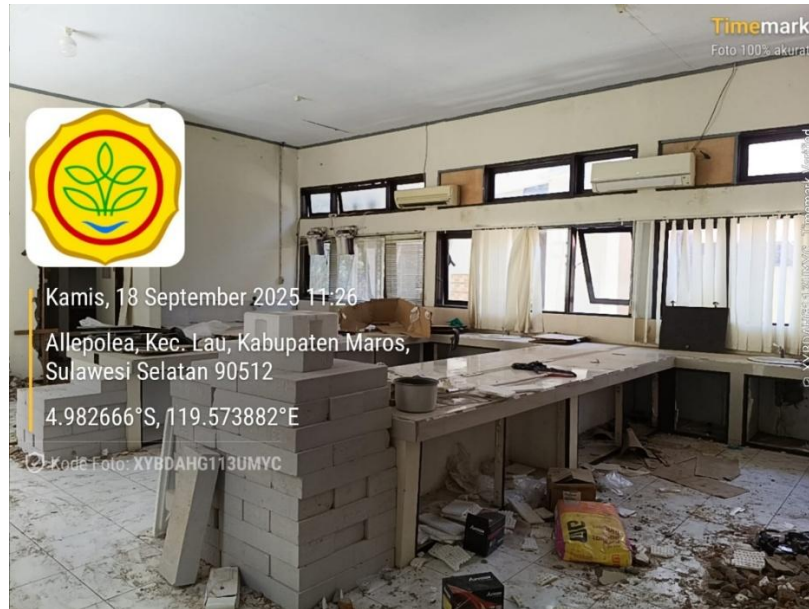
Perbaiki atap dan ruangan pada laboratorium biomolekuler
